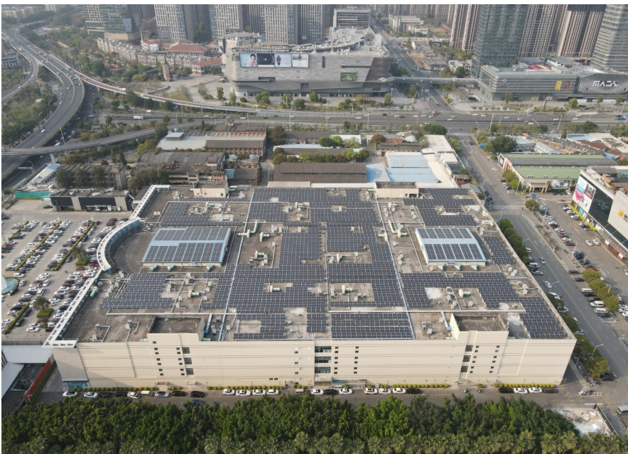
2020年10月，meteocontrol采用VCOM解决方案，成功帮助福建福州喜盈门屋顶工商业项目实现并网发电，光伏装机容量为1.15MWp。
