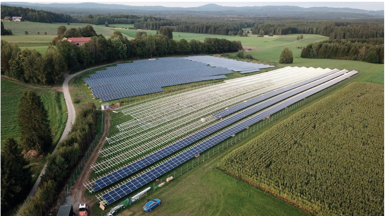
图 2 安装光伏发电厂
